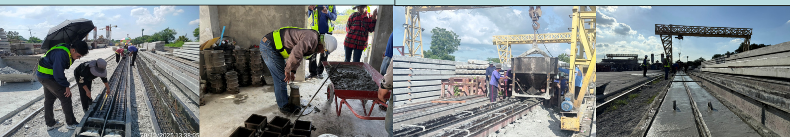
งานหล่อเสาเข็มคอนกรีตอัดแรง ขนาด 0.22x0.22 ม.
