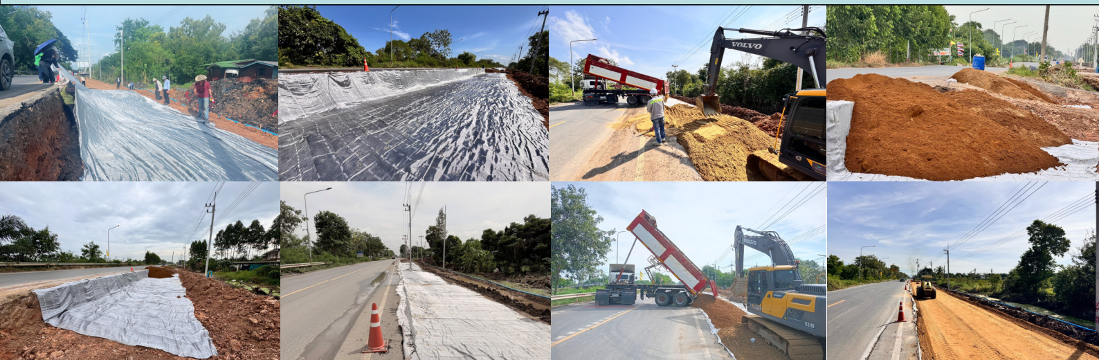
งานปูแผ่นใยสังเคราะห์ Woven Geotextile รับแรงดึงไม่น้อยกว่า 100 kN
